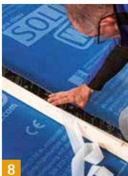
TESCON NAIDECK mono Taquet d'étanchéité sous forme de ruban en caoutchouc butylique
