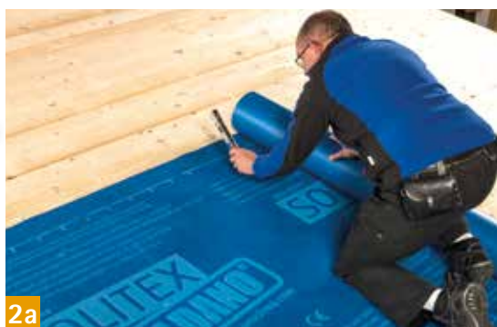
SOLITEX WELDANO Ecran de sous-toiture ouvert à la diffusion, permettant un soudage homogène
