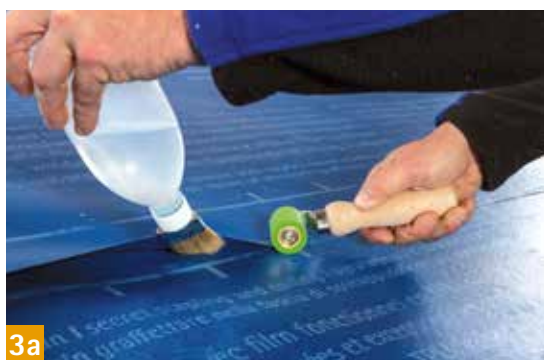
WELDANO TURGA Solvant de soudure pour le système d'écran SOLITEX WELDANO
