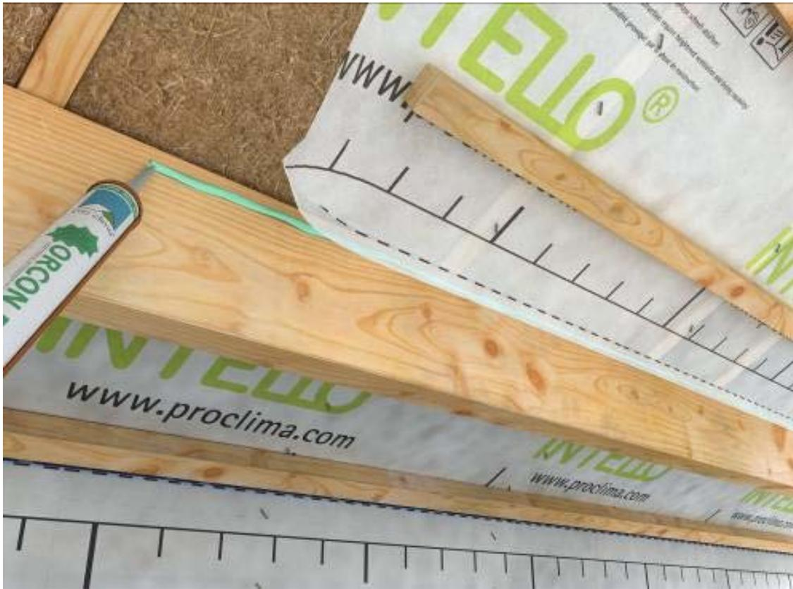
Figure 27 : Raccord à une panne intermédiaire à l'aide de la colle de raccord mastic
