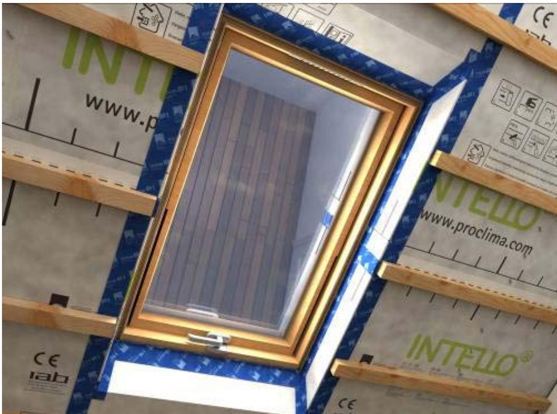
Figure 28 : Raccord à une fenêtre de toit à l'aide du ruban adhésif pro clima TESCON PROFIL
