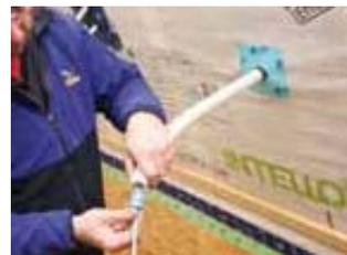
Figure 7 : Mise en place du bouchon STOPPA
