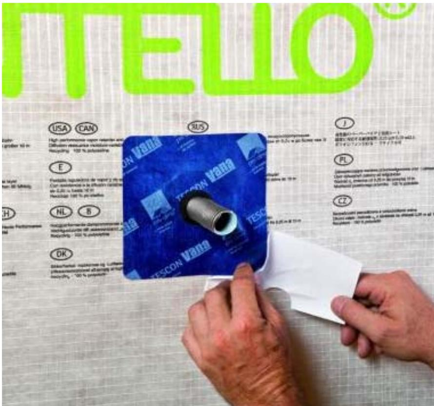
Figure 30 : Mise en place de la manchette ROFLEX 20
