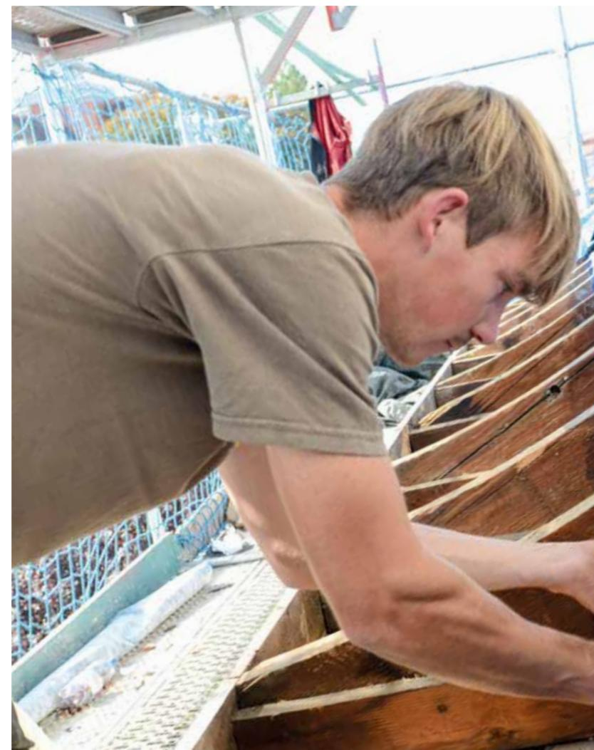
Selon la conception, la pose à plat d'une membrane d'étanchéité à l'air sur les chevrons est simple. Ici aussi, le défi se loge dans les détails : pour le raccord en pied de versants, des cornières pré-fabriquées facilitent nettement la réalisation de raccords étanches à l'air.
