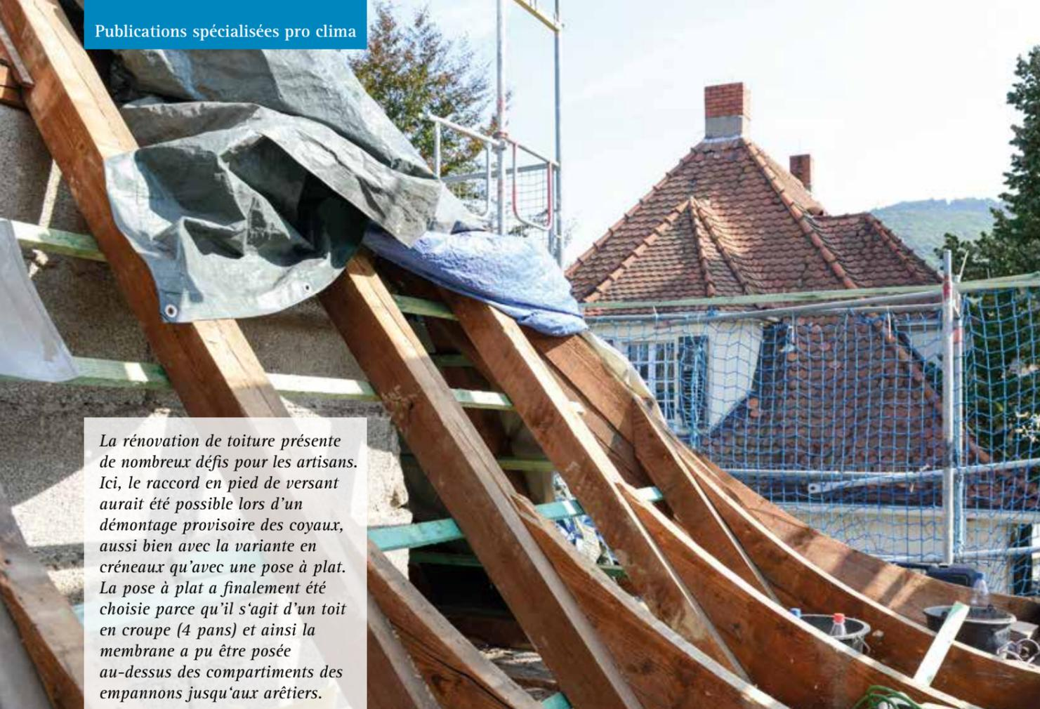
La rénovation de toiture présente de nombreux défis pour les artisans. Ici, le raccord en pied de versant aurait été possible lors d'un démontage provisoire des coyaux, aussi bien avec la variante en créneaux qu'avec une pose à plat. La pose à plat a finalement été choisie parce qu'il s'agit d'un toit en croupe (4 pans) et ainsi la membrane a pu être posée au-dessus des compartiments des empannons jusqu'aux arêtières.
